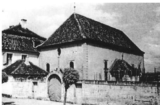
Das einstige Gemeindezentrum. Links im Anschnitt das Rabbinerhaus, rechts daneben die Synagoge und davor in der Mitte die Mikwe – das Tor in der Friedhofsmauer als Zugang zum Friedhof.
